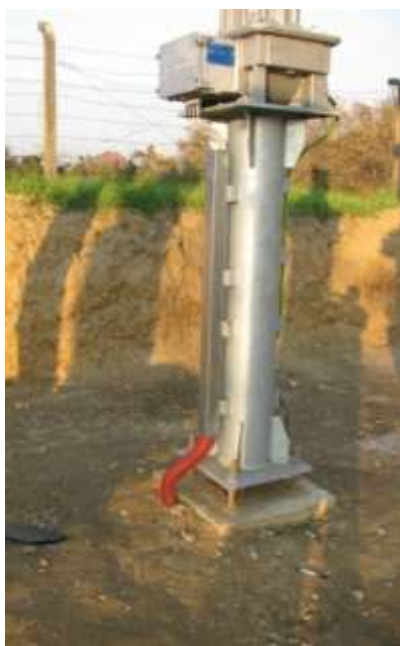
Пример на изведба на кабелски врски на ВН опрема
